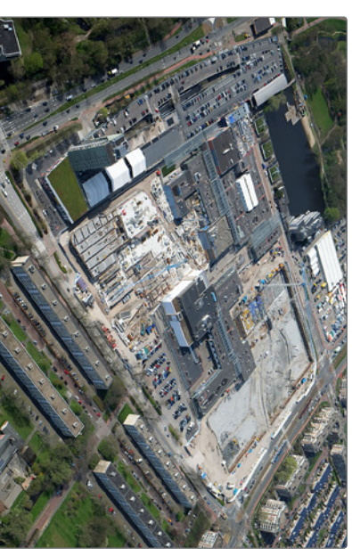
Situatie bouw april 2018
